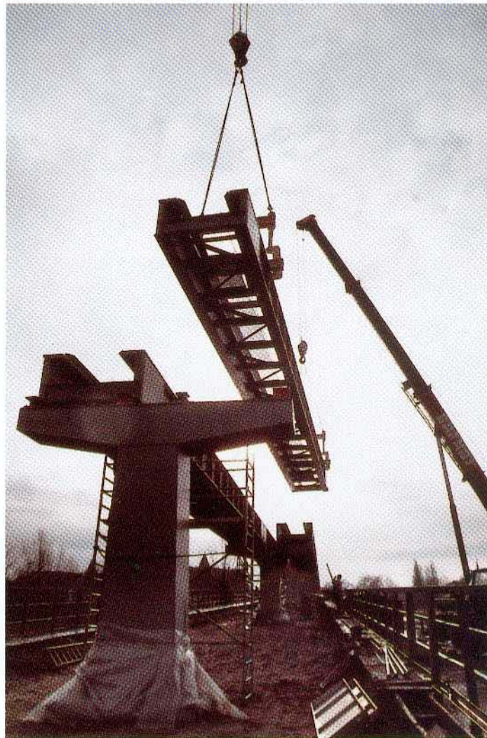
3 Fahrwegstützen und -träger können in kurzer Zeit montiert werden
